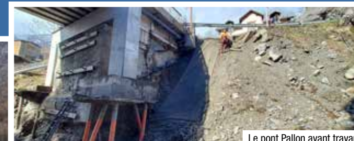
Le pont Pallon avant travaux
