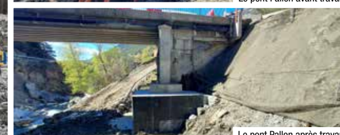
Le pont Pallon après travaux
