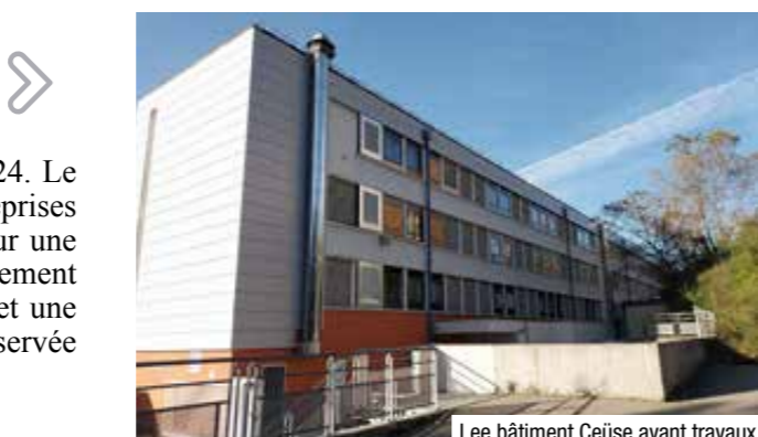
Le bâtiment Ceüse avant travaux
