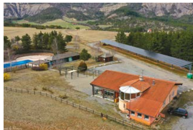
Ombrières photovoltaïques sur l'aérodrome de Mont-Dauphin-Saint-Crépin.
