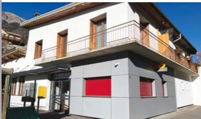
La mairie rénovée de Saint-Clément-sur-Durance
