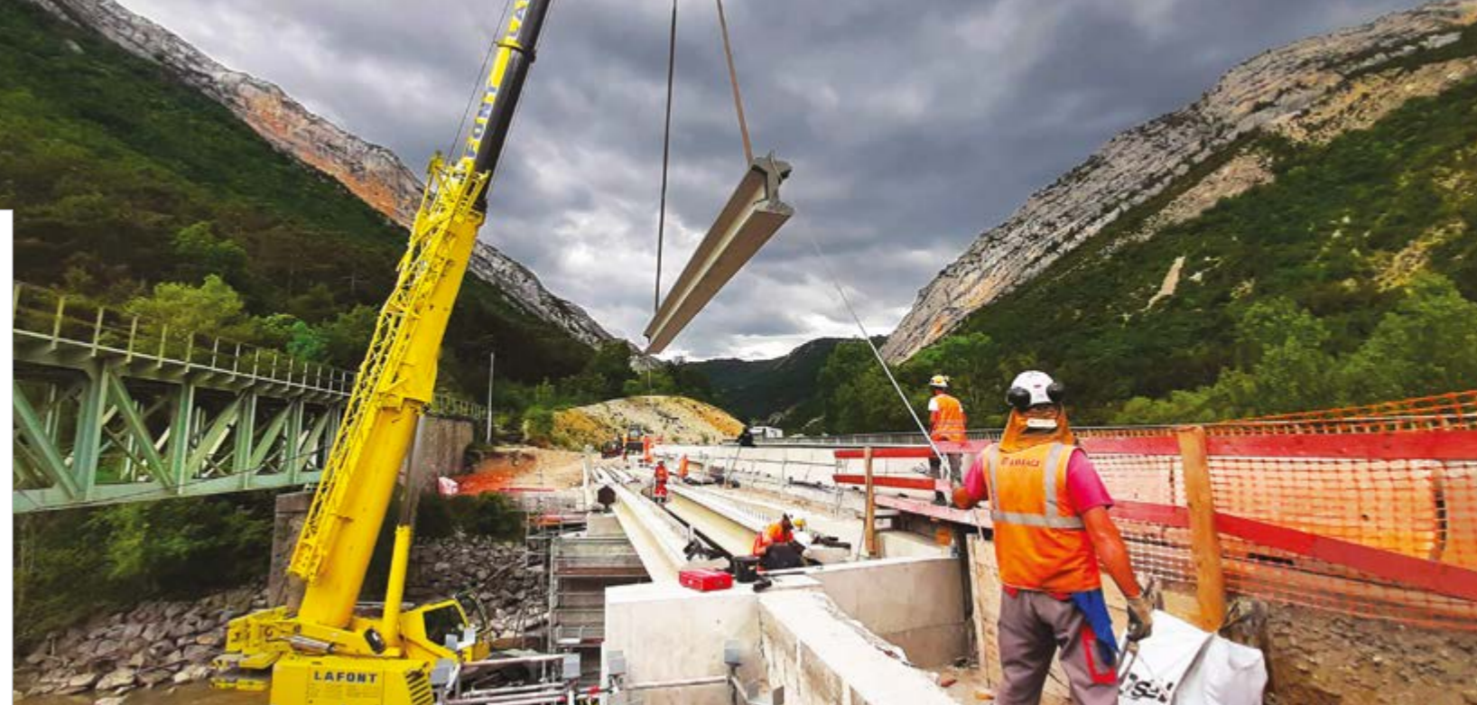
Grutage des poutres de Pont La Barque (RD 1075)
