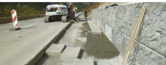
Soutènement de la bande cyclable du Lautaret
