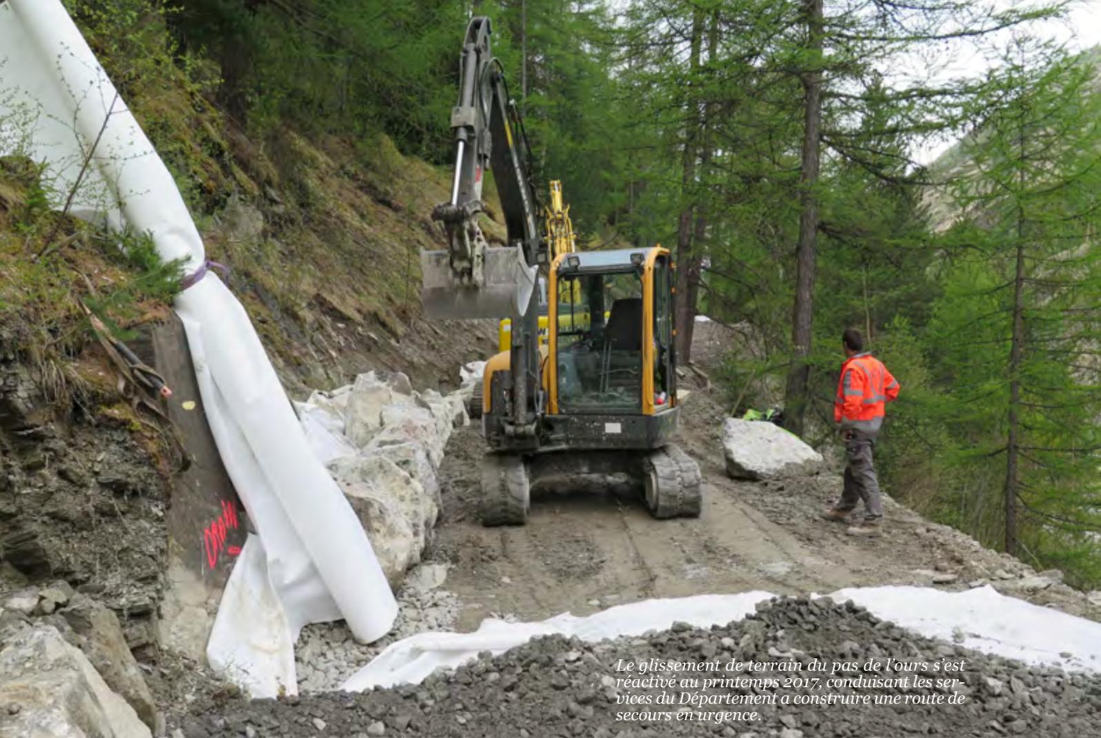
*Le glissement de terrain du pas de l'ours s'est réactivé au printemps 2017, conduisant les services du Département à construire une route de secours en urgence.*
