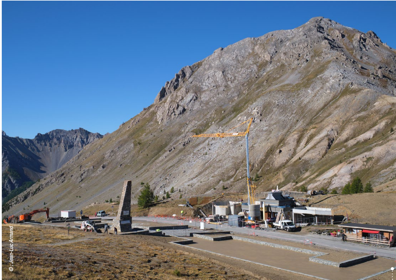
Les travaux au col d'Izoard seront terminés d'ici la fin du mois d'octobre.
