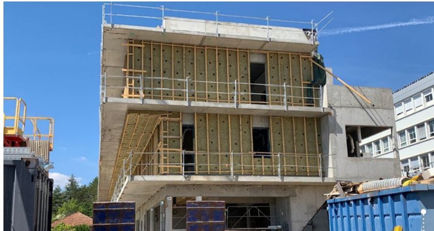
Reconstruction d'un des bâtiments du collège de Laragne-Montéglin.
