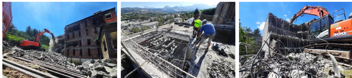
Le chantier des Archives départementales des Hautes-Alpes se poursuit comme prévu avec la démolition des trois quarts du bâtiment actuel. La livraison des nouveaux locaux est prévue pour l'automne 2023.
