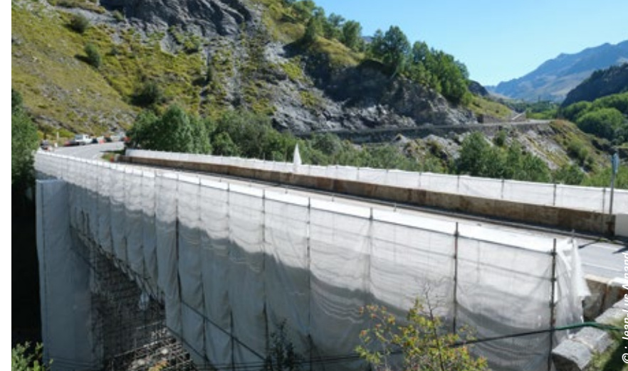
Les travaux de confortement de ce pont qui date du XIX e siècle vont durer plus d'un an.
