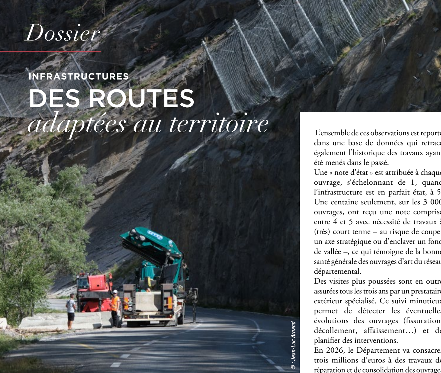
Travaux de sécurisation dans les gorges du Guil.
