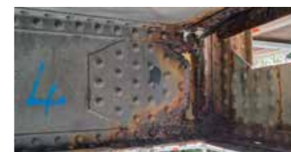
Le pont des Andrieux avant travaux
