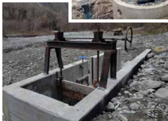
Nouvelle prise d'eau de l'Asa du canal de Lachaup (Saint-Maurice-en-V.)
