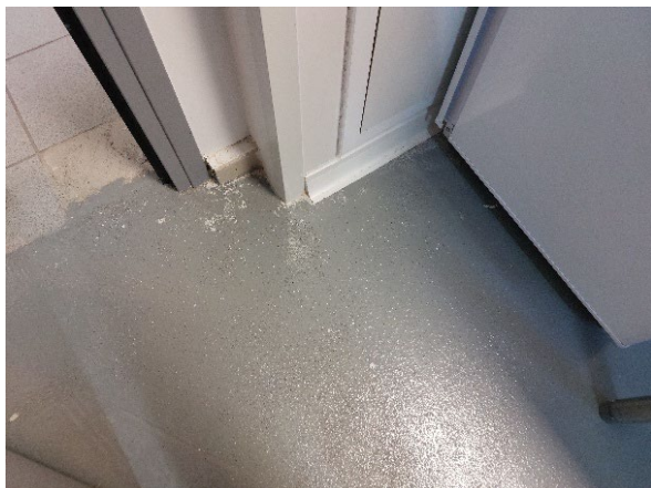
Résine au sol avec traces d'enduit
