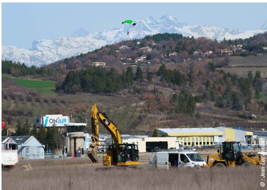
Des travaux de terrassement ont précédé l'installation des dalles en polypropylène recyclé.
