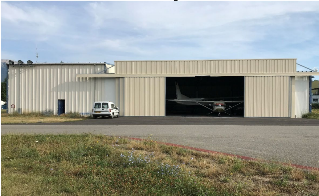
Photo du hangar n°17
