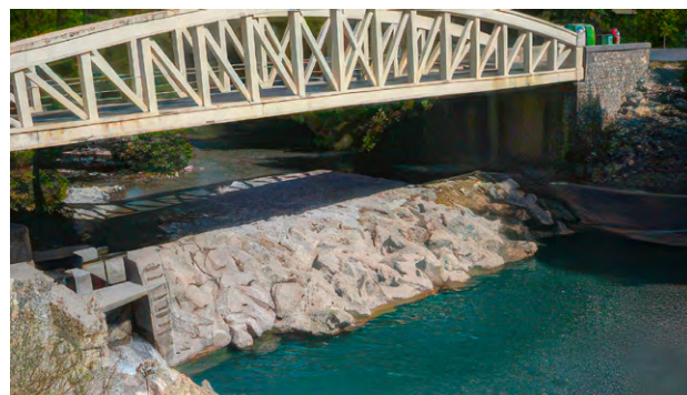
Seuil infranchissable avant travaux
